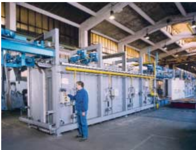
BILD 2: Neue Wärmebehandlung mit Härteofen, Tauchbecken und Anlassofen
